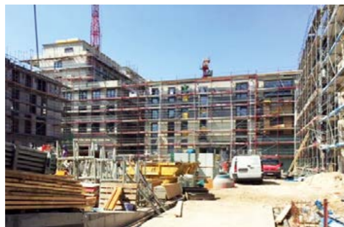
DIE LEITUNGEN SIND BEREITS VERLEGT
