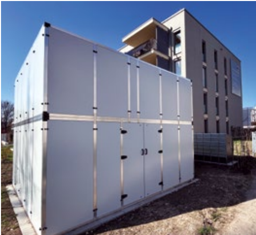
Komponentenbeispiele Wärmepumpe für Mehrfamilienhäuser mit Schallschutzeinhausung [oben], Wärmepumpe [unten]
